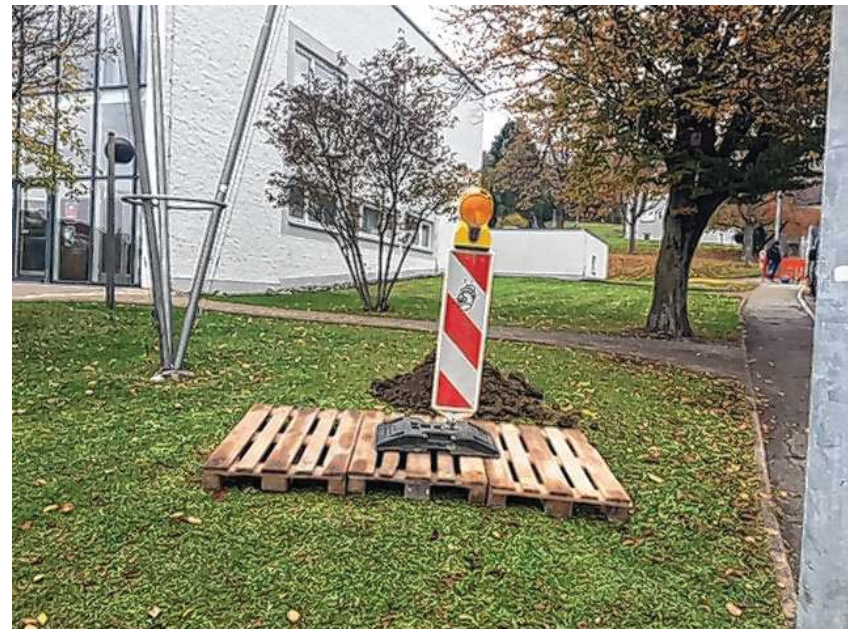
Die Fundamente bei der Grieshaber Halle
