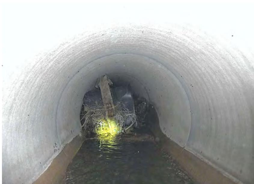
*Unschwer ist zu erkennen, dass der Querschnitt von 1,60 m Durchmesser nahezu komplett verstopft ist!*
